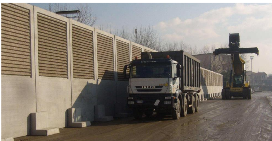
Figura 6-c – immagine di esempio di installazione di una barriera mobile
