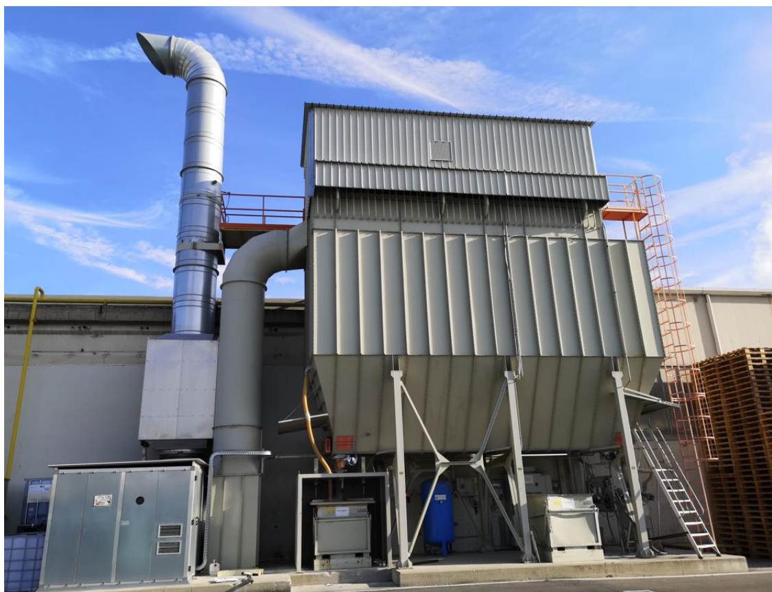
Figura 3-w – Il filtro attualmente esistente
